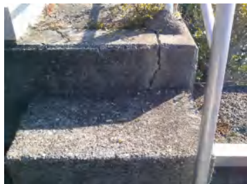
ひび割れ箇所
