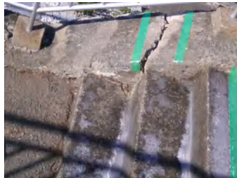
ひび割れ箇所
