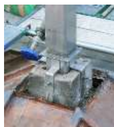
写真-1. 芯材の固定状況
