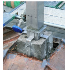
写真-1.芯材の固定状況
